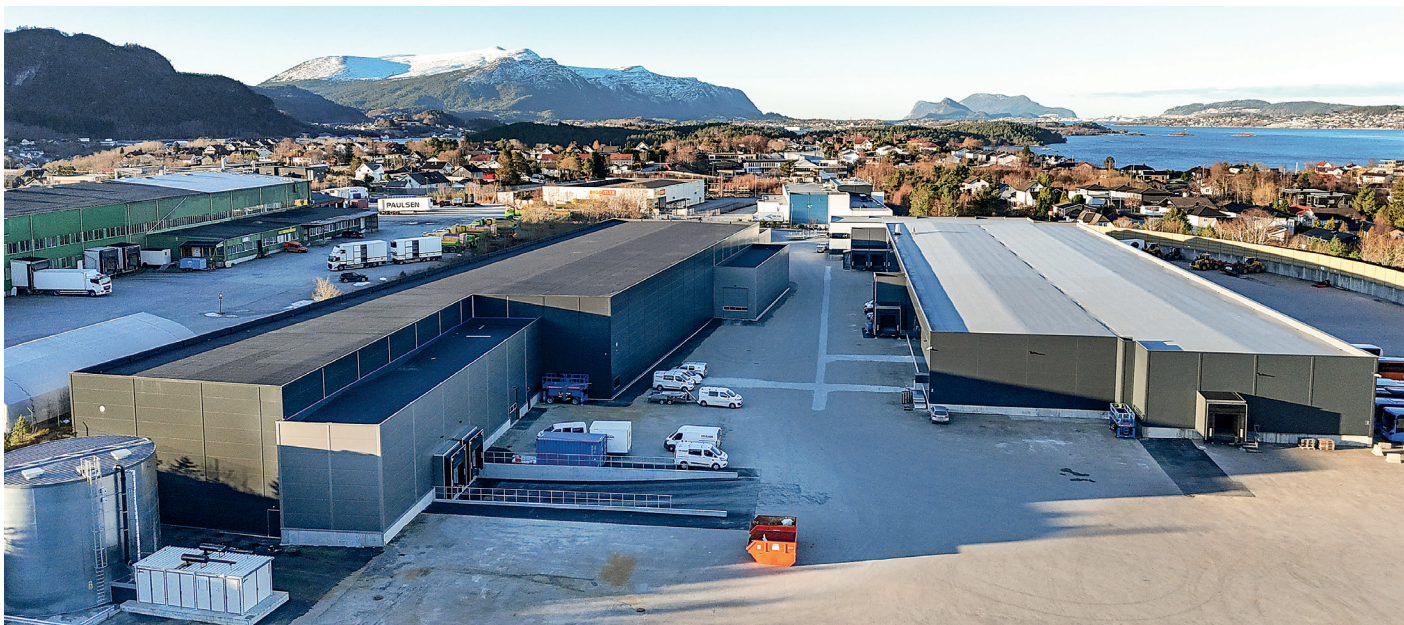
Eiendomsmassen til Waagan Eigedom i Blindheim Industriveg 4 er på over 10.000 kvadratmeter totalt. Byggene er fullt utleid. I det nye bygget til høyre holder dekkaktørene Starco og Dekkteam til, mens Tine er største leietaker i det totalrehabiliterte bygget til venstre.
