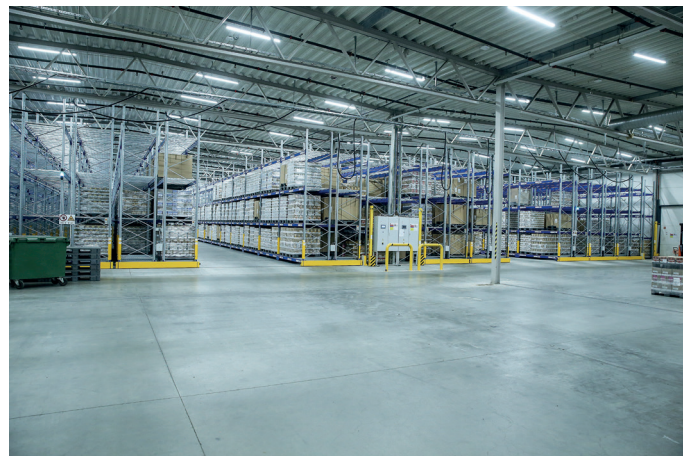
Fra Tines lagerområder i det totalrehabiliterte eksisterende næringsbygget.
