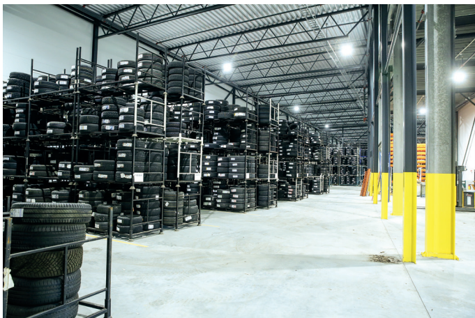
Enorme mengder dekk blir lagret inne i det nye bygget. Vi ser stålkonstruksjonene som holder sandwichpaneler og tak på plass.
